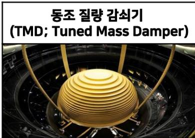
**동조 질량 감쇠기 (TMD; Tuned Mass Damper)**
